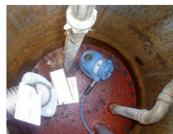
Obr. 2 Radarové vysielače Rosemount 5300 nainštalované na podzemných zásobníkoch s minimálnym prístupom zvrchu a možnosťou pripojenia. Potrubia zasahujú až do vnútorného priestoru zásobníka.
