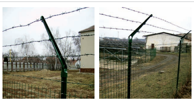
Obr. 7 Detail vrcholovej zábrany z ostnatého drôtu
